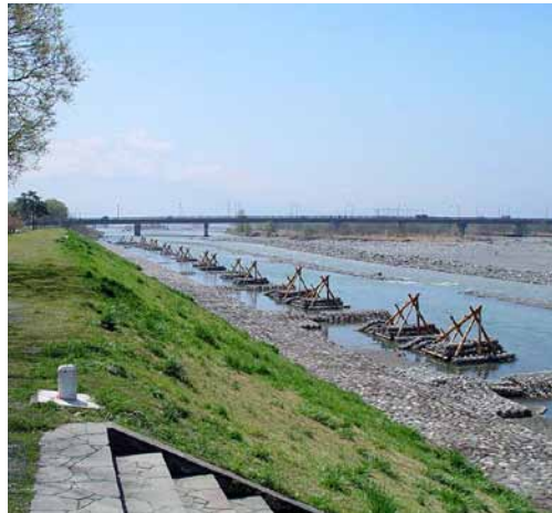
信玄堤 写真提供: 山梨県甲府河川国道事務所
